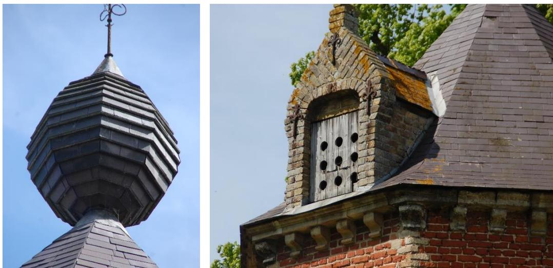
*Détail du bulbe en ardoises avec épi en plomb et détail d'une lucarne à fronton maçonné*
