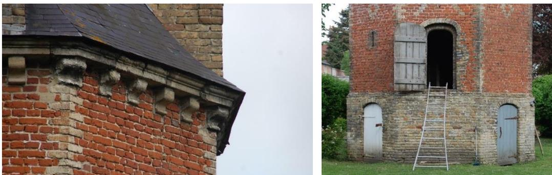
*Détail de la corniche en pierre de taille avec entablement et modillons (à gauche) et détails du soubassement et des trois portes d'accès au pigeonnier (à droite)*
